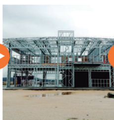
Estrutura metálica 30 dias
