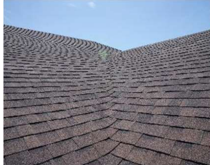
Água Furtada (Telhas Entrelaçadas)
